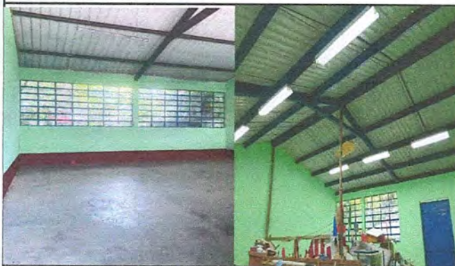
Foto 3: Mejora e instalación de vidrios de ventanería e instalaciones y reparaciones eléctricas ejecutados en su totalidad.
