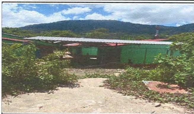
Foto 1: Vista general en el centro educativo con el remozamiento ejecutado en su totalidad.
